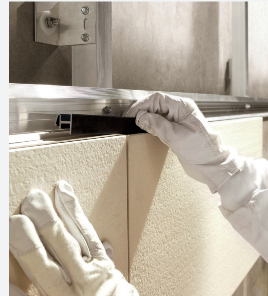
SISTEMA SUPER PLUS Anclaje por guías horizontales FVI SUPERPLUS Attachment with horizontal guides
